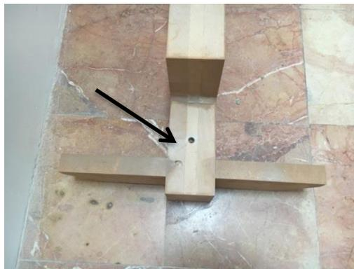
Fixer ensuite le petit limon dans le sol pour solidariser l'ensemble de l'escalier. Pour cela réalisez un repère puis faire un trou au perforateur dans le sol puis replacer le limon et visser avec une vis  $\varnothing 6 \times 200$  ou  $\varnothing 6 \times 180$
