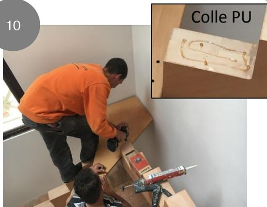
Collez à la colle polyuréthane puis vissez la marche d'angle dans le pré-trous avec les vis  $\varnothing 5 \times 70\text{mm}$
