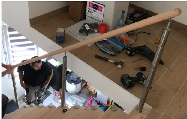
Mettre en place la main courante centrée sur les poteaux. A l'aide d'un réglet mesurer qu'elle dépasse des 2 côtés de la même longueur.
