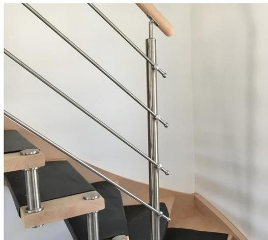
Installer les 4 tiges en inox puis coller les billes de finitions en inox à chaque extrémités des tubes avec de la colle forte type cyanoacrylate.
