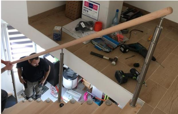
Mettre en place la main courante centrée sur les poteaux. A l'aide d'un régleur mesurer qu'elle dépasse des 2 côtés de la même longueur.
