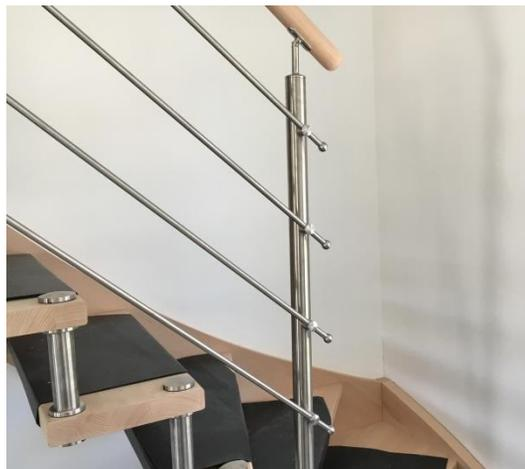
Installer les 4 tiges en inox puis coller les billes de finitions en inox à chaque extrémités des tubes avec de la colle forte type cyanolite.
