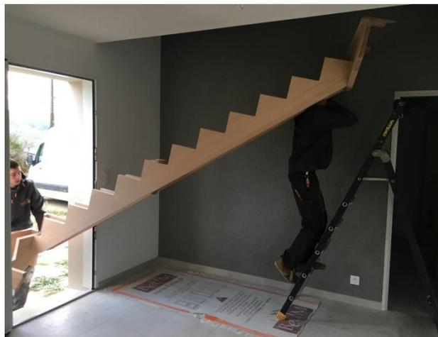
Fixer deux cales en bois aux extrémités de la dernière marche afin de créer un support pour accrocher l'escalier sur la dalle. Visser dans les pré-trous pour ne pas repercer la marche. Ces deux cales seront retirées à la fin de l'installation.
