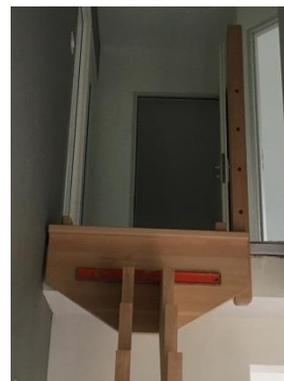
Placer le limon à 34-35 cm du mur. Vérifier que l'écartement soit identique partout. Vérifier aussi que l'escalier soit de niveau en posant un niveau à bulle en haut de l'escalier.
