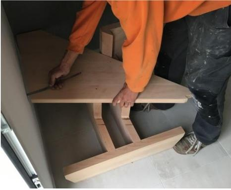
Commencez par installer la marche d'angle en laissant 15 millimètres entre le mur et la marche
