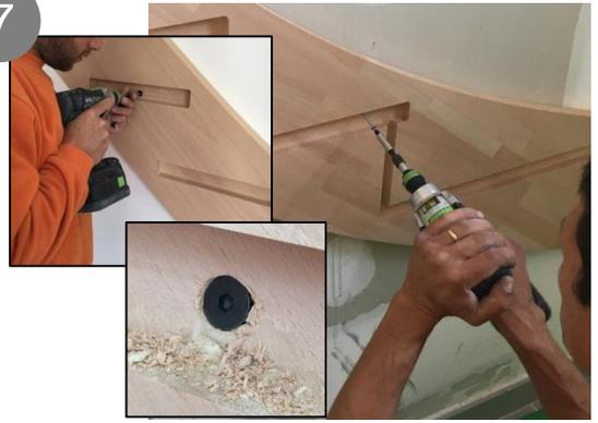
Visser toutes les vis dans les trous. Si besoin fraiser avec un foret à bois pour ne pas laisser dépasser la tête de vis.
