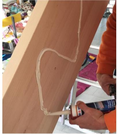
Retirer le limon du mur et encoller l'arrière du limon avec une colle néoprène en cartouche à l'aide d'un pistolet à colle manuel.
