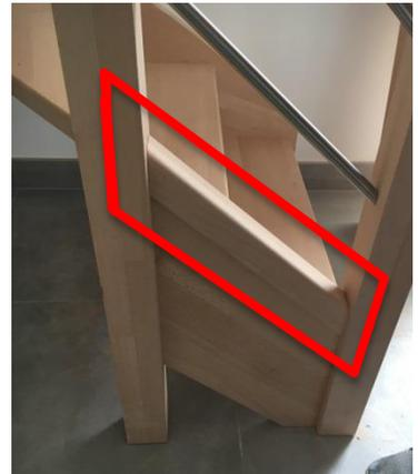
Sur la première volée, encoller la lisse basse avec de la colle néoprène puis la coller sous les lisses en inox directement sur le limon intérieur.
