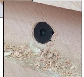
Répéter les opérations 4,5,6,7 pour le limon n°2 : placer le limon sur votre repère tracé au crayon précédemment puis le coller et le visser au mur avec des vis Ø10 et des chevilles molly.
