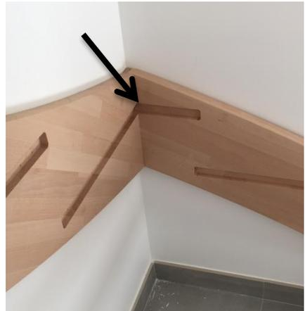
Mettre en place le quart tournant (limon contre le mur). Les deux entailles de la marche d'angle de l'escalier doivent être bien en face l'une de l'autre. Tracer un repère sur le mur au crayon lorsqu'il est bien en place.
