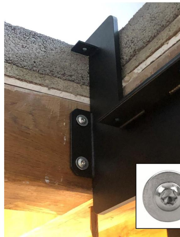
Vérifier que le limon est de niveau, puis le fixer à la dalle d'arrivée à l'aide des vis « ASSY »
