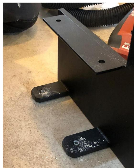
**Fixer le limon au sol** : percer le sol dans les trous de la platine du limon avec une mèche de  $\varnothing 8$
