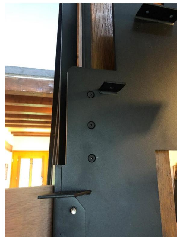
Installer le(s) garde-corps rampants : visser à l'aide d'une clé Allen dans les perçages prévus à cet effet le long des limons intérieurs avec les vis **FHc M6x25**.
