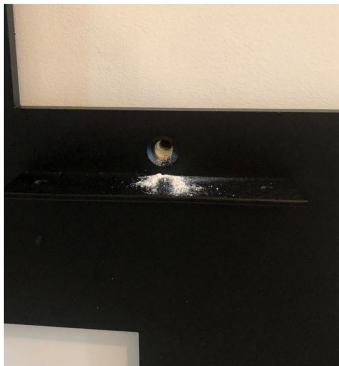
Percer avec la perceuse dans tous les trous du limon avec une mèche de  $\varnothing 8$ .
