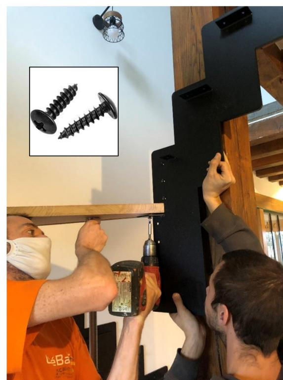
Mettre en place le limon intérieur de la volée supérieure. Se repérer avec la marche d'angle, puis visser la marche au limon pour solidariser l'ensemble.
