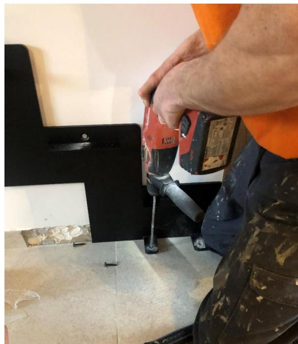
**Fixer le limon au sol** : percer le sol dans les trous de la platine du limon avec une mèche de  $\varnothing 8$ . Mettre des chevilles nylon de  $\varnothing 8$ . Visser avec les vis à penture 6x35 fournies. Renouveler l'étape pour les 2 trous.
