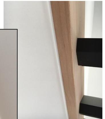
Finition : faire un joint au mastic acrylique blanc sur tous les angles en contact avec les murs. (Au dessus et en dessous des limons fixés aux murs).
