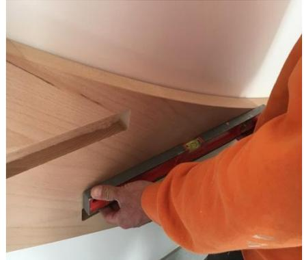
Ajuster le limon jusqu'à ce que les entailles de marches soient de niveau. Toujours vérifier le niveau avec un niveau à bulles. Une fois le limon bien en place, tracer un trait de repère sur le mur.
