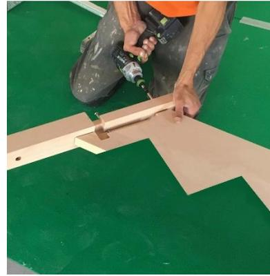
Visser le poteau de l'arrivée de l'escalier au limon crémaillère avant de la mettre en place. Utiliser les vis 8x100 ou 8x80 fournies.
