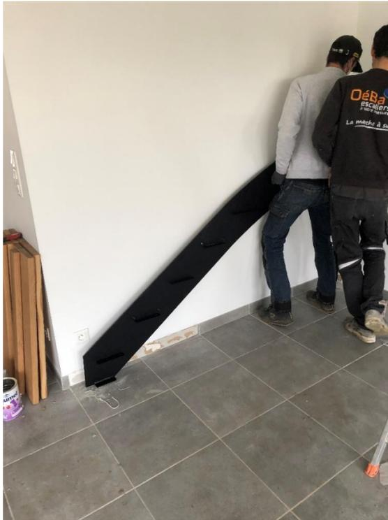
Encoller le limon du côté mur avec la colle de montage blanche néoprène
