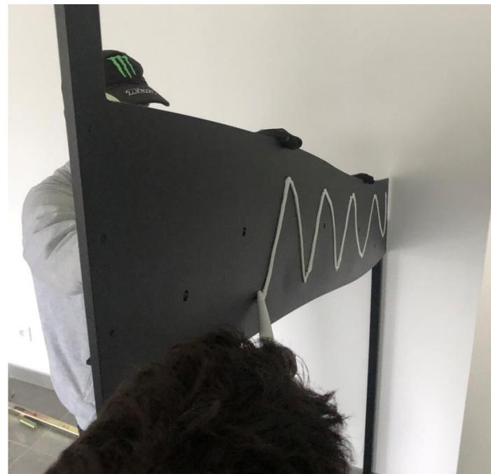
Vérifier que le limon soit de niveau, puis le coller au mur avec la colle de montage blanche néoprène
