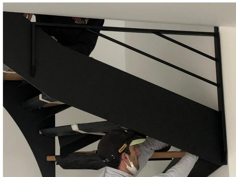
Installer le(s) claustras : visser à l'aide d'une clé Allen dans les perçages prévus à cet effet (au niveau de chaque poteau) le long des limons extérieurs avec les vis **FHc M6x25**.
