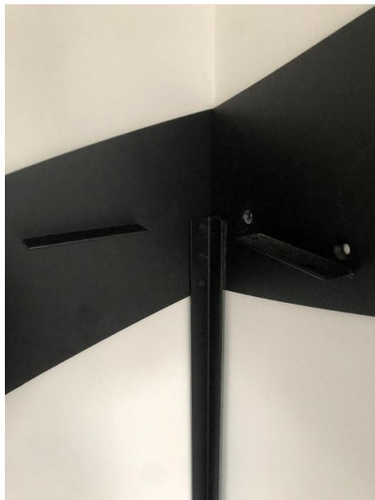
Visser entre eux les limons extérieurs 1 et 2 à l'aide des 3 vis **FHc M6x25** et d'une clé Allen.
