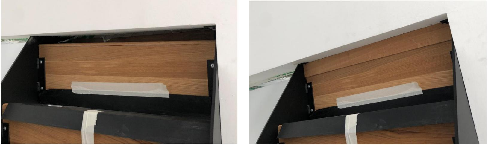
Recouper si besoin, puis placer et clouer un champlat sous l'arrivée de l'escalier afin de cacher le trou formé par l'avant dernière marche et la contremarche.
