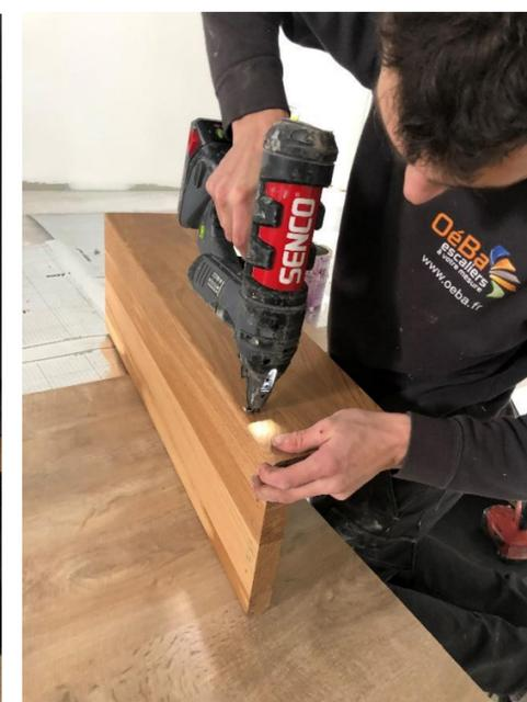
Assembler : coller et pointer l'avant dernière marche de l'escalier avec la contremarche d'arrivée. Utiliser des pointes têtes d'hommes ou un cloueur pneumatique. Utiliser de la colle polyuréthane en cartouche.
