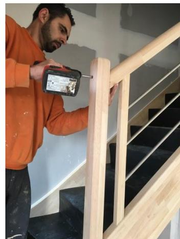
Enfin, installer la rambarde (=garde corps rampant) le long de la montée de l'escalier entre les poteaux. Visser la main courante en bas et en haut dans les trous prévus, avec les vis 6x90 fournies.
