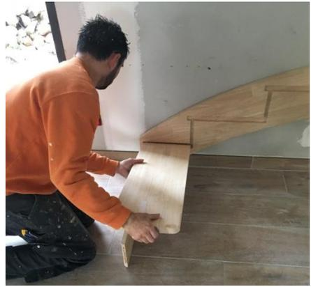
Une fois les marches d'angle installées, vous pouvez mettre en place la 1<sup>ère</sup> contremarche. Mettre de la colle polyuréthane sous la 1<sup>ère</sup> marche (au niveau du décroché) et dans l'entaille du limon de la marche n°1. Installer la 1<sup>ère</sup> marche sur la 1<sup>ère</sup> contremarche.
