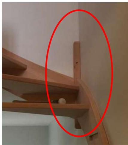
Mettre en place le limon de la volée n°1 en faisant correspondre les entailles des marches au niveau dans l'angle. Placer le petit poteau d'angle à ce moment là pour connecter les 2 limons.
