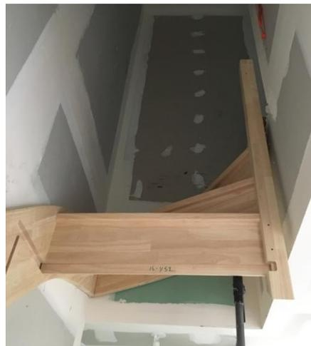
Mettre en place le poteau d'angle entre la 2<sup>ème</sup> et la 1<sup>ère</sup> volée de l'escalier. Faire correspondre les entailles du poteau avec les marches. Frapper à l'aide d'un maillet et plastique pour bien solidariser le poteau et les marches ensemble.
