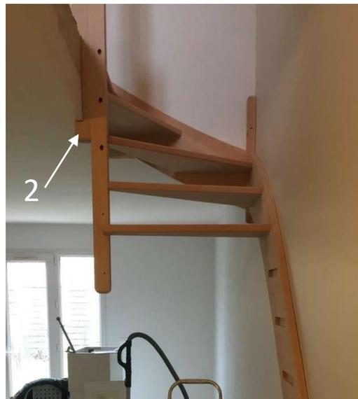
Placer le poteau d'angle (N°1 sur l'image : celui qui recevra le garde-corps), puis ensuite placer le poteau d'arrivée de l'escalier (N°2 sur l'image : celui raccordé à la dalle).
