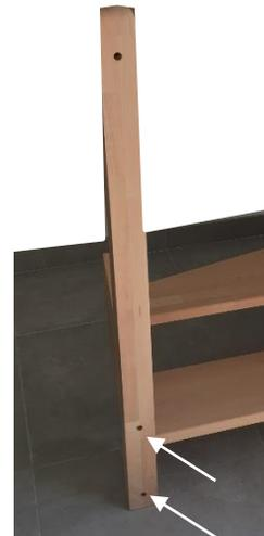
Une fois que l'ensemble est bien installé, et que tout est de niveau (marches et poteaux), visser dans les pré trous des poteaux de départ de l'escalier et d'angle, au limon intérieur.
